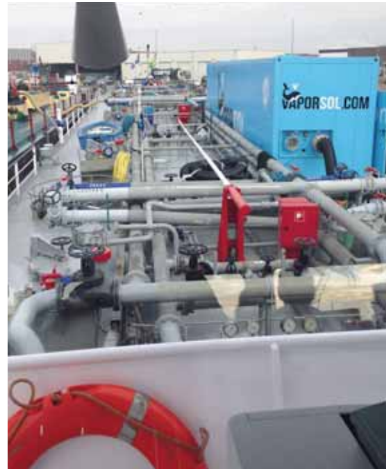
Vaporsol-unit (Vaitec1) aan boord van een binnenvaarttanker
